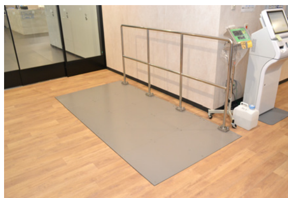
入院透析室の入口にはベッド体重計を設置
