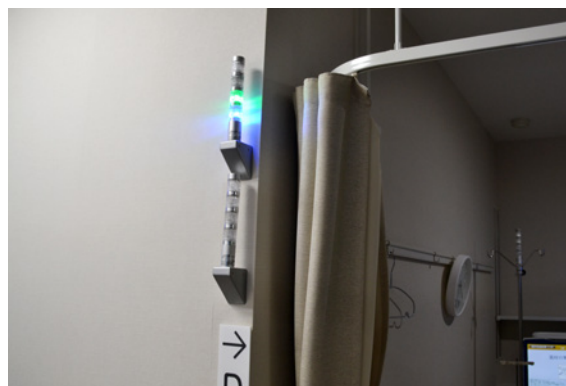
個室透析室内の状況は部屋の外に設置したライトの色で識別する
