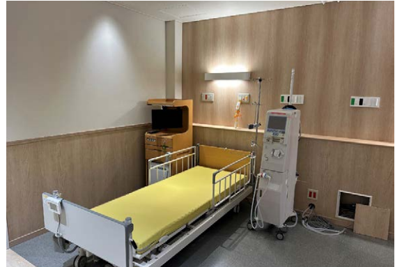
個室透析室。感染症患者などが利用する （写真提供：三橋明生病院）
