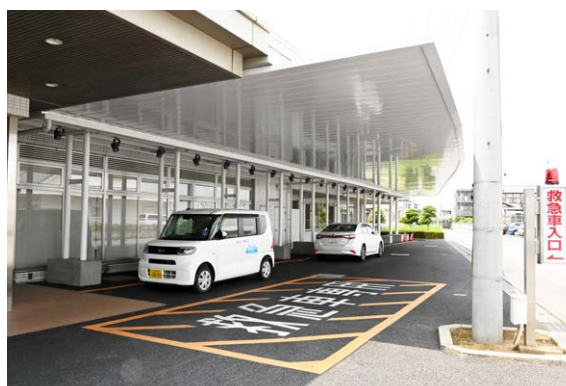
大きなひさしを設けた救急総合診療センター出入口。透析患者の送迎もここを起点とするため雨を避けることができる
