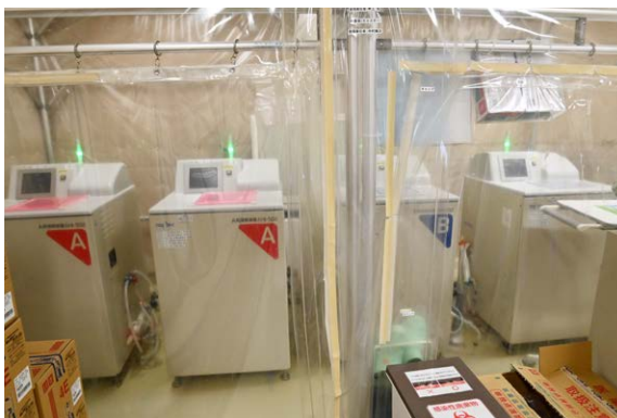
機械室には空気中の低濃度粒子を捕集できるHEPAフィルターを備えたクリーンブースを備えている。水処理システムは故障時などに備えバイパスでつながる2系統を完備
