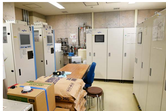
機械室には空気中の低濃度粒子を捕集できるHEPAフィルターを備えたクリーンブースを備えている。水処理システムは故障時などに備えバイパスでつながる2系統を完備
